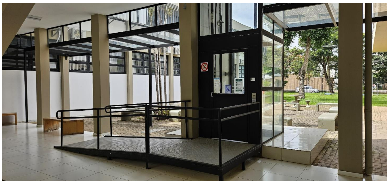
Figura 35 - Utilização de elevador e rampa
