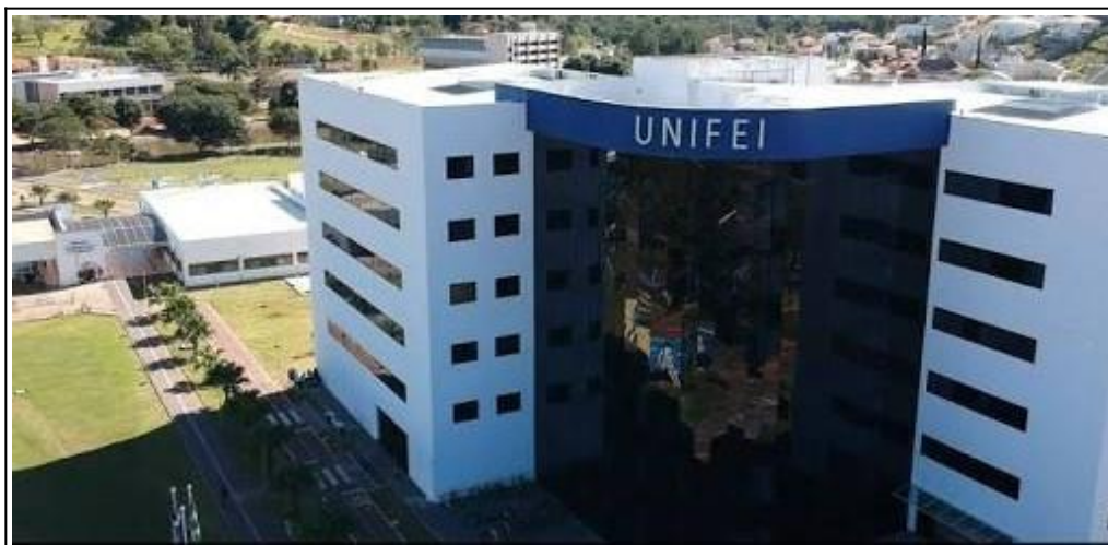
Figura 13.3 – Imagem aérea mostrando o Prédio da Administração Central (em primeiro plano) e parte do Centro de Serviços e Convivência (logo atrás do primeiro, à esquerda).
