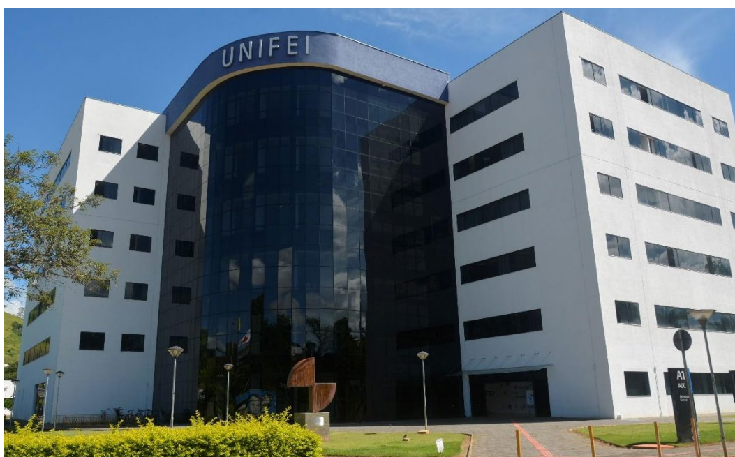
Figura 1 – Prédio da Administração Central
