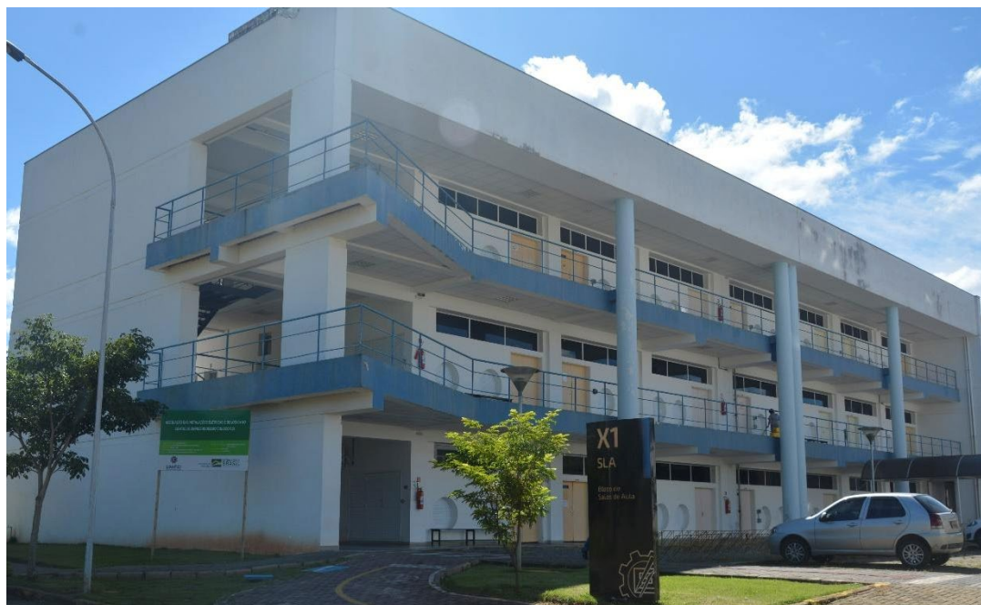
Figura 4 – Bloco X de Salas de Aula
