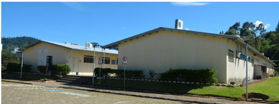
Figura 7 – Instalações do Centro de Estudos em Química
