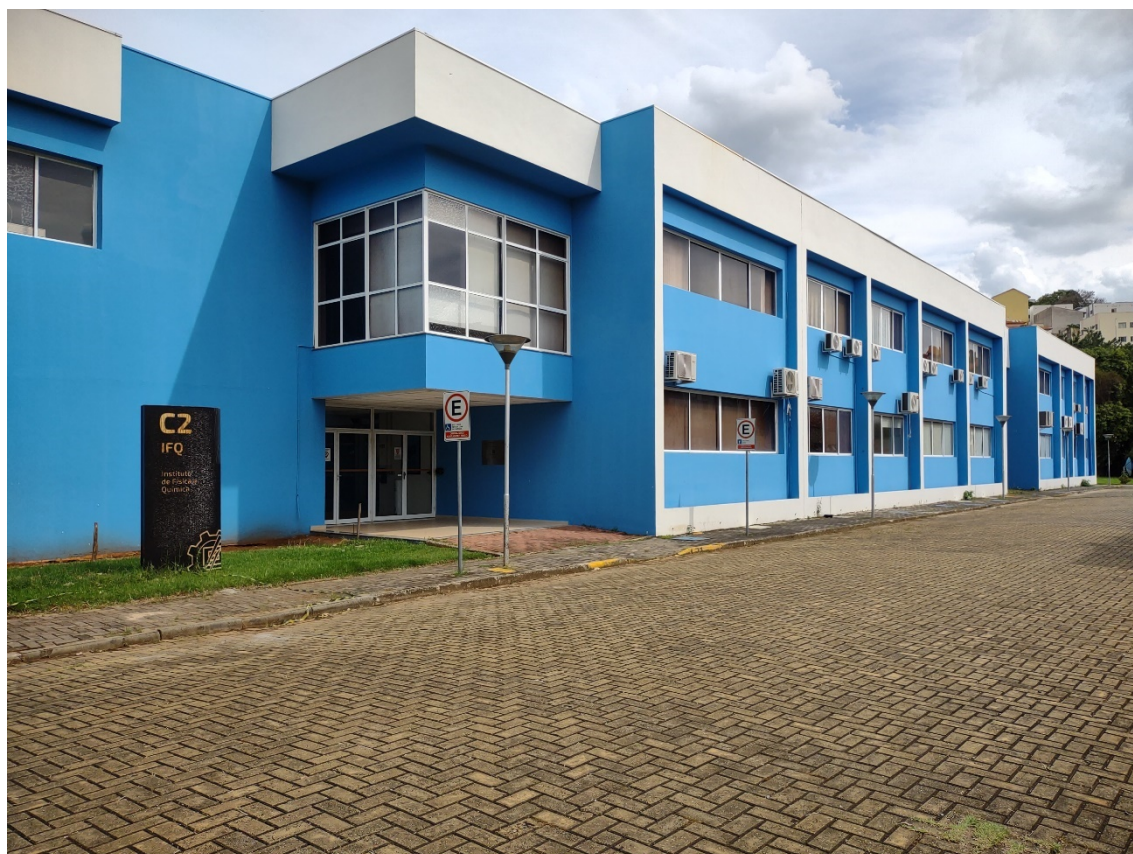
Figura 6 – Prédio do Instituto de Física e Química
