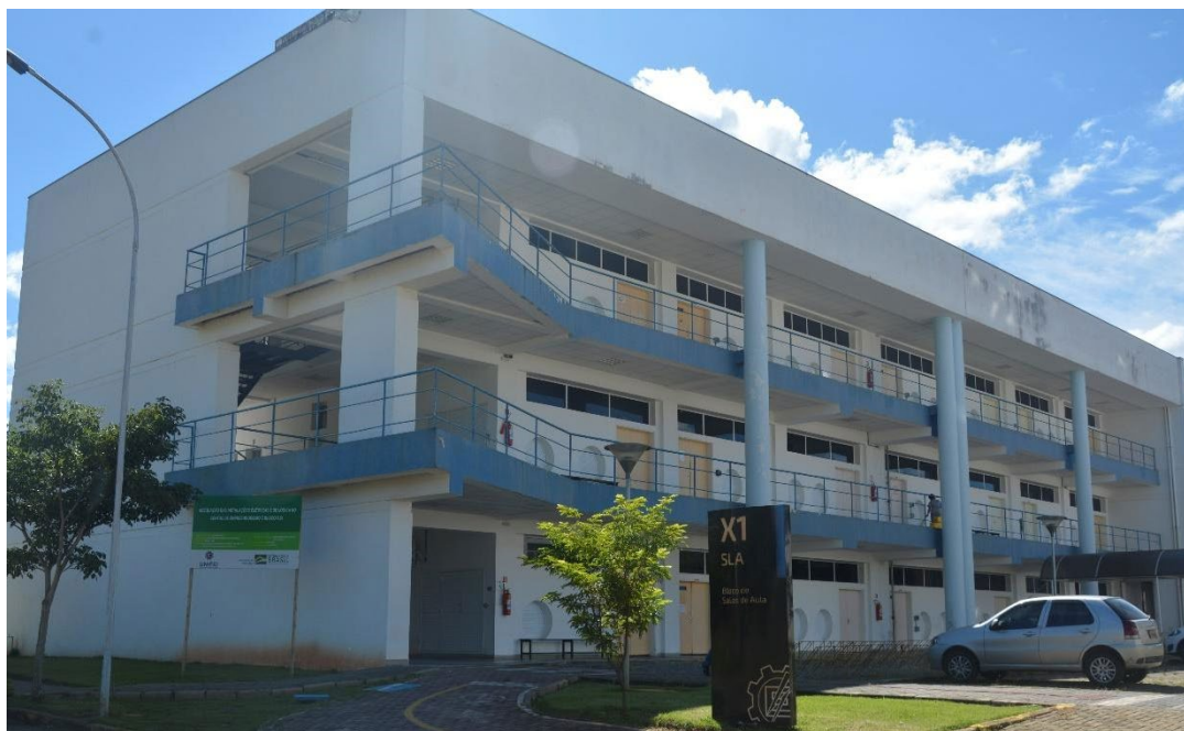
Figura 4 – Bloco X de Salas de Aula
