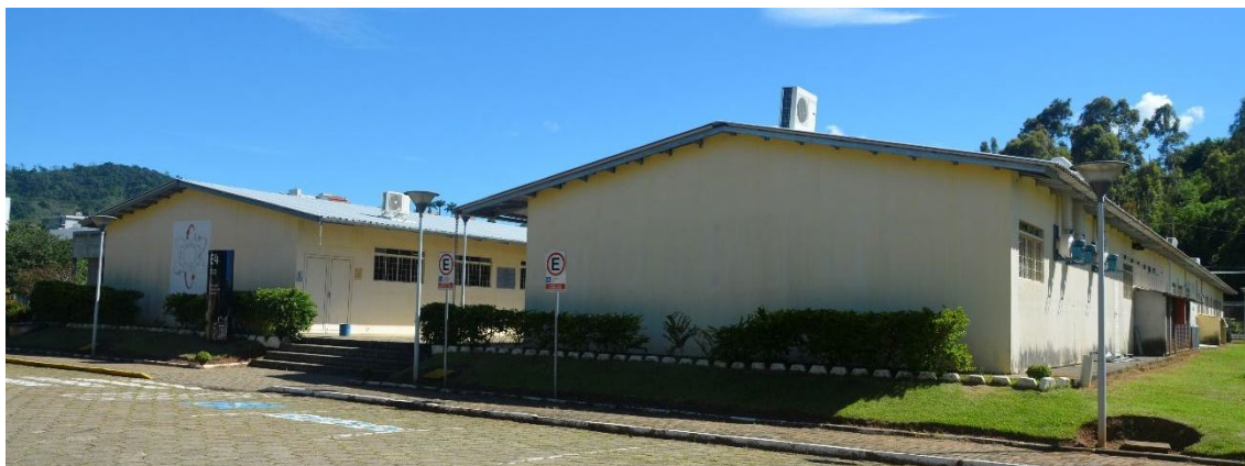
Figura 7 – Instalações do Centro de Estudos em Química
