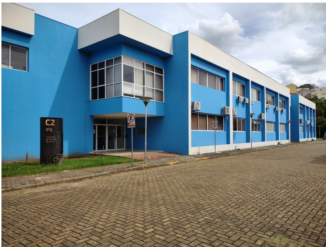
Figura 6 – Prédio do Instituto de Física e Química
