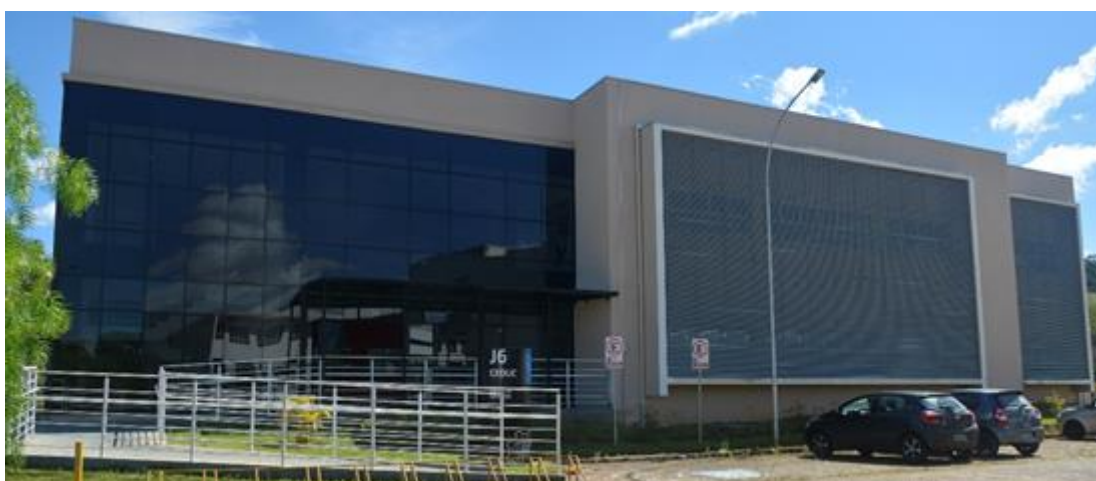
Prédio do Centro de Educação Fonte: Coordenação do curso de Química-Licenciatura
